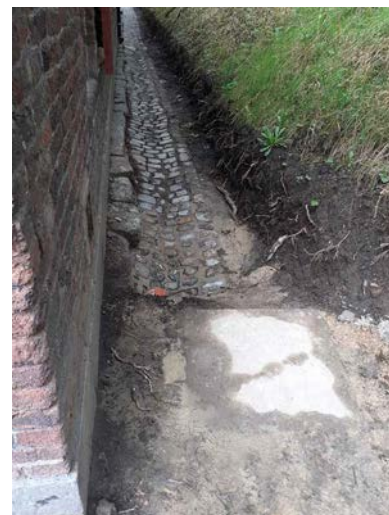
▲ Rigole découverte à l'arrière du Hangar
