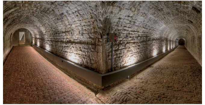
▲ Souterrains menant vers la caponnière hollandaise (à droite) construite entre 1815 et 1830 © Vincent Ferooz-Pixel Komando
