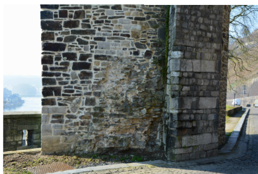
▲ Arrachement du mur de courtine
