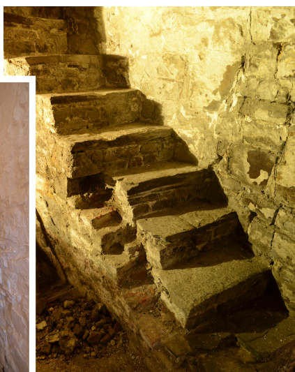
▲ Escalier en pierre de la tour César avant restauration © DDGM Architectes
